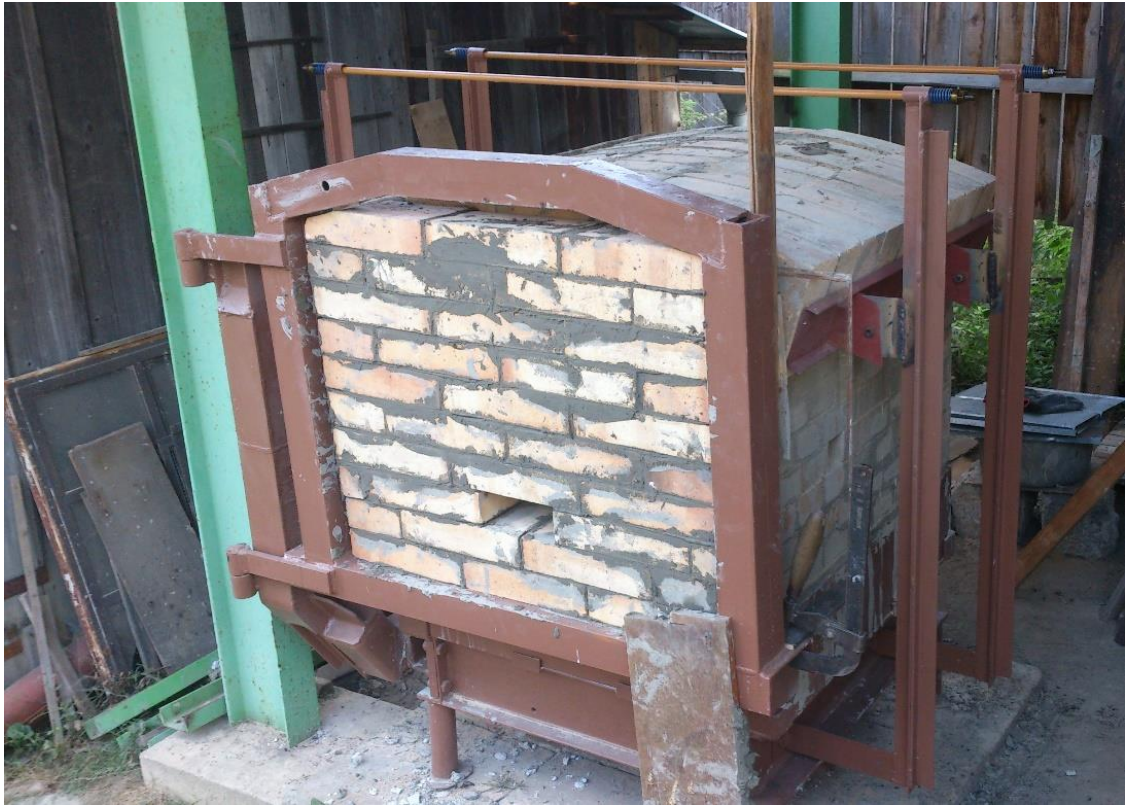
Obr. 41: Zdění dveří kalící komory
