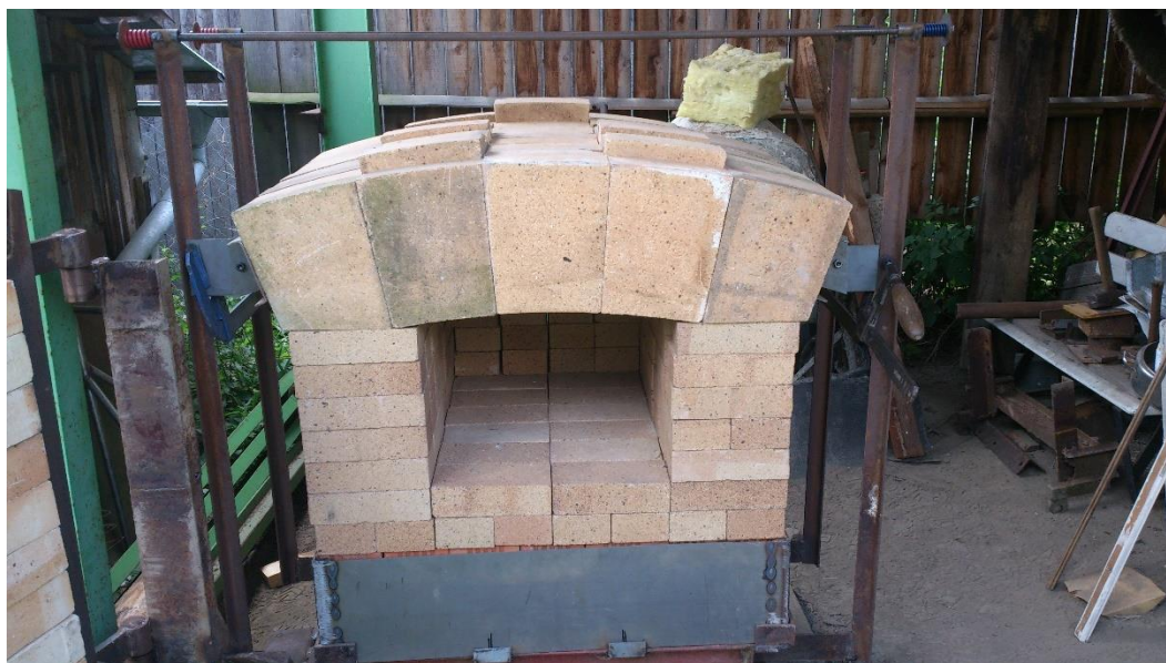
Obr. 33: Zkušební sestavení stropu
