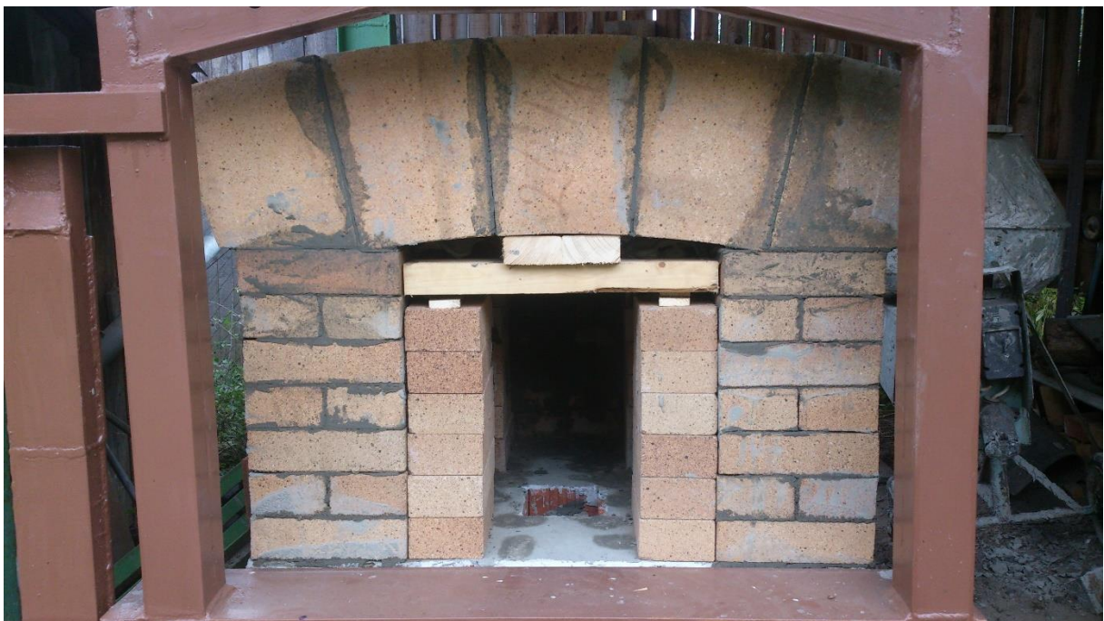
Obr. 40: Stavba stropu kalící pece
