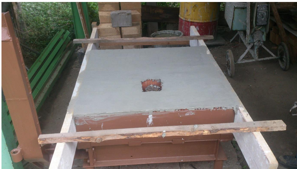
Obr. 37: Nanášení samonivelační vrstvy
