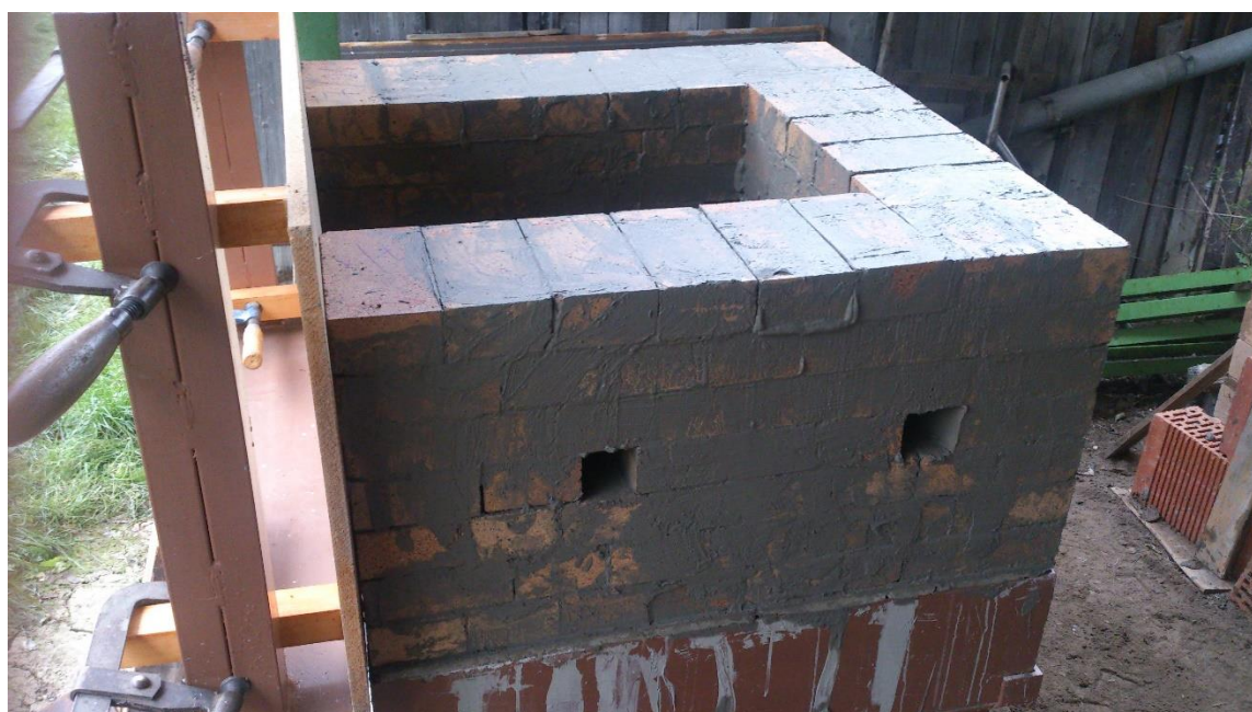
Obr. 38: Zdění kalící komory
