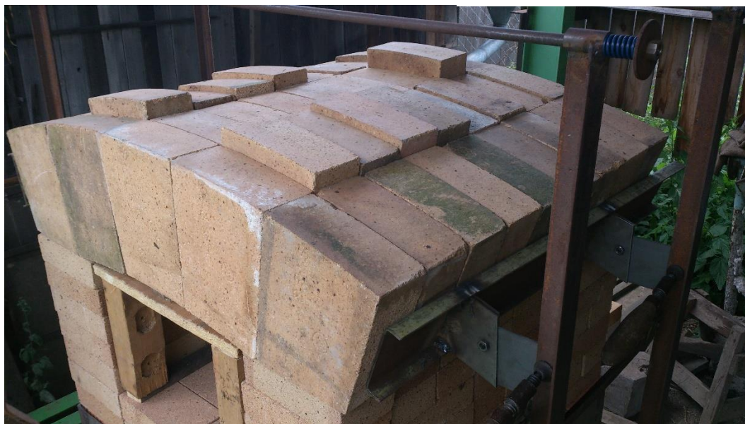
Obr. 34: Detail na mechanismus zachytávající roztažnost
